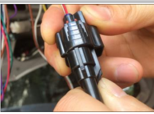
3.12 接尾门信号线：用我司配的信号线转接头对插，注意图片拍摄角度
